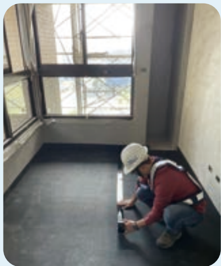
7.接縫防水處理
